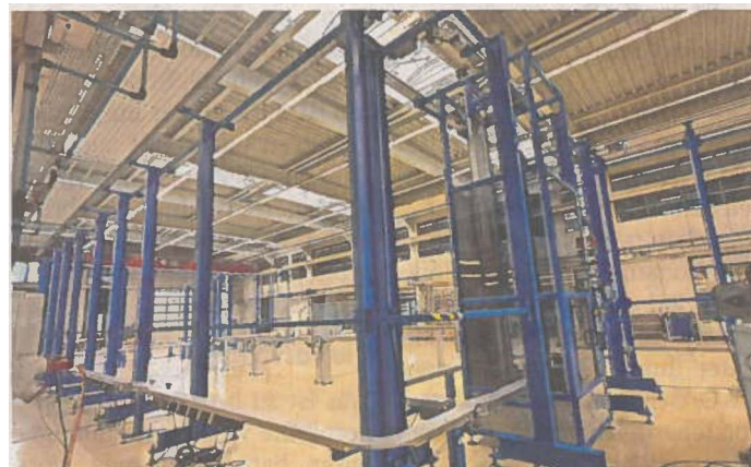
Diese Anlage soll künftig beim Recyclen von Elektroschrott eingesetzt werden.
